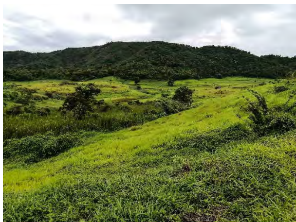
Foto 36. Vista geral da área onde estão situados os pontos de DP20 a DP22, monitoramento da Barragem Duas Pontes, município de Amparo, SP, 2ª. campanha, janeiro de 2021. Autor: J. Cassimiro.
